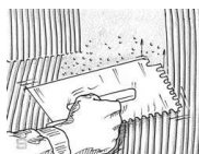
Mortel met kamspaan verdelen op isolatieplaten.
