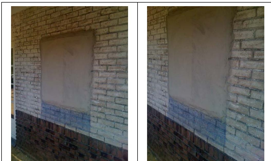
Een correct aangebracht proefvlak met het weefsel in het midden van de laag
