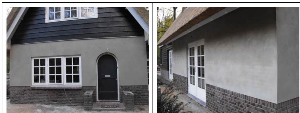
Een raaplaag aanbrengen van MKG-SL en de sinterhuid verwijderen of opschuren
