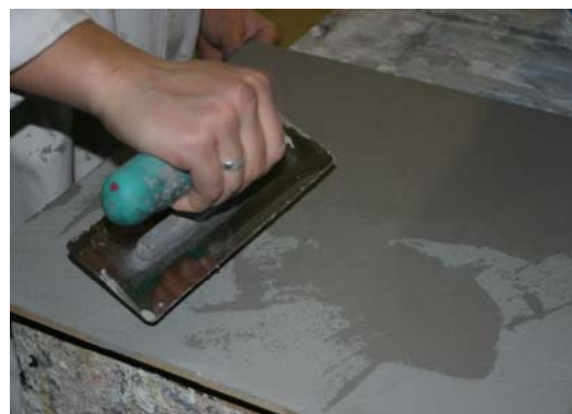
Na droging Effects Concrete Finitura aanbrengen.
