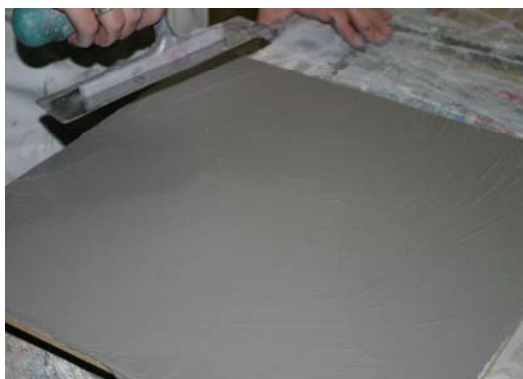
Na enige droging de niveauverschillen pletten met een speciale inoxspaan.
