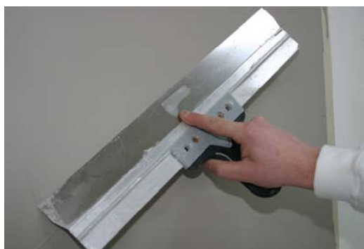
Aansluitend met behulp van een Spackmes glad afmetten.
