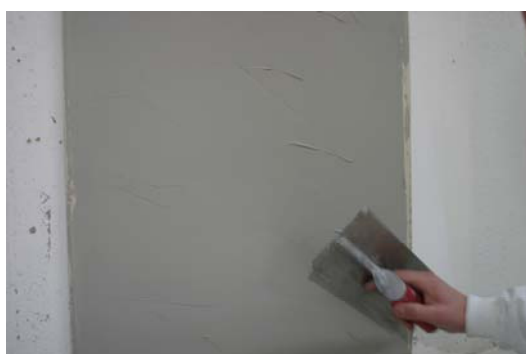
Vervolgens direct in de nog natte meslaag met een RVS spaan een tekening aanbrengen.
