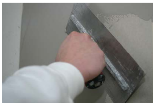
Spacks Innovance Basis opbrengen met een roestvaststalen spaan. (of machinaal)
