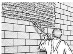
De mortel handmatig of machinaal aanbrengen.
