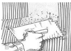
Een 1 e laag handmatig of machinaal aanbrengen.
