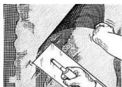
Het weefsel overlappend (min. 100 mm) inbedden.
