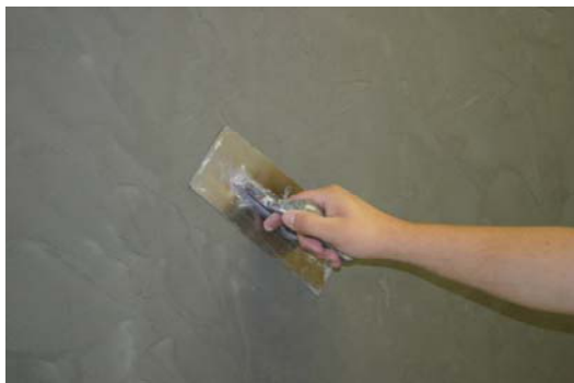
Na enige droging de niveaoverschillen pletten met een speciale inox spaan.
