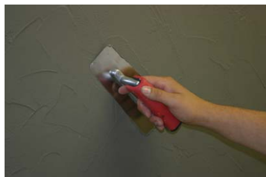
Veel kleine spaanslagen zorgen voor veel schakeringen in het eindresultaat.
