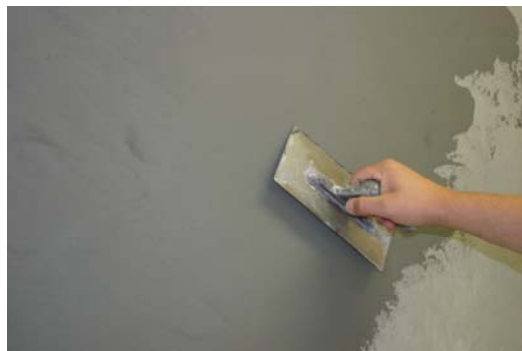
Na een droging van 24 uur, Silikalk Rasatura aanbrengen.
