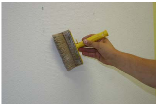
De ondergrond voorbehandelen met Effects Fixafond B500.
