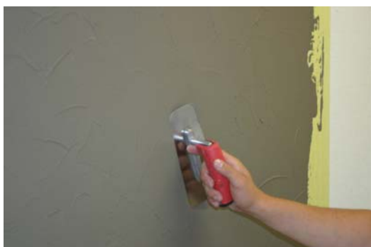
in deze laag een tekening maken met een speciale inox spaan.
